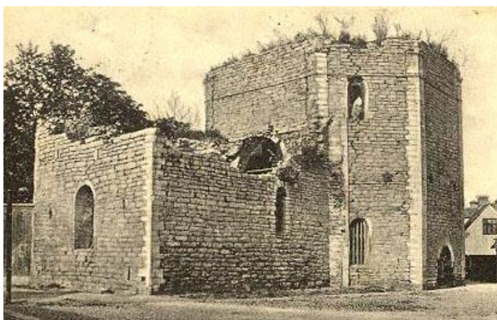
Fig. 4: Helge And i Visby på ett vykort från 1905, med sitt oktagonala kor, vilket varit uppfört i två våningar (källa, se ref. lista).
